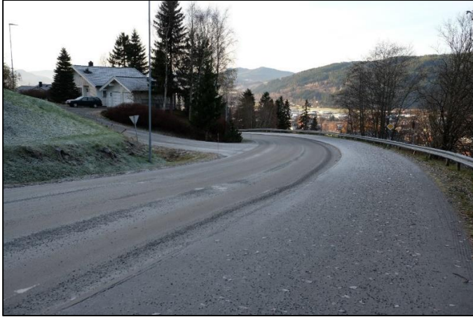
Figur 15 Hovsbakkveien, sett mot sør.
